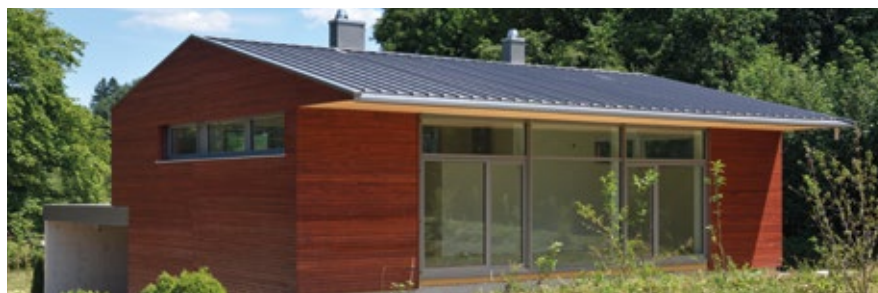
Wohnhaus mit ROMA Dach
