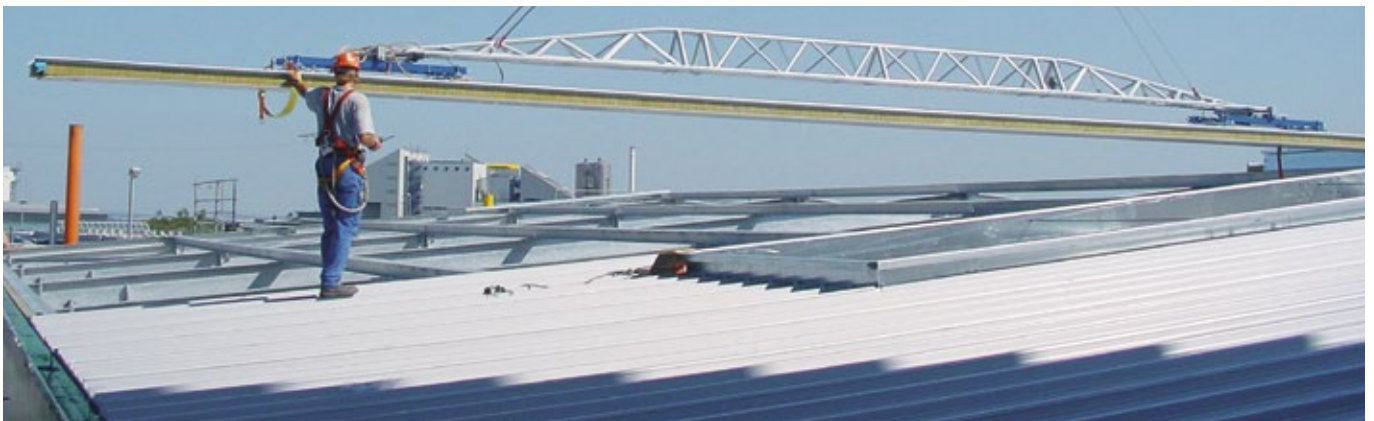
Beispiel einer Dachmontage mit Traverse
