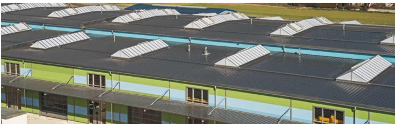
Produktionshalle mit 24 m langen Dachpaneelen
